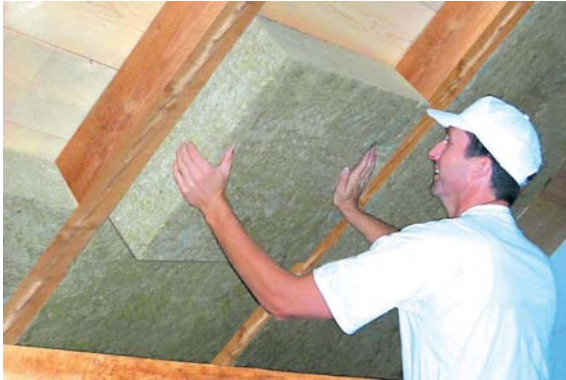
Heralan-KP Platten zwischen die Sparren klemmen.
