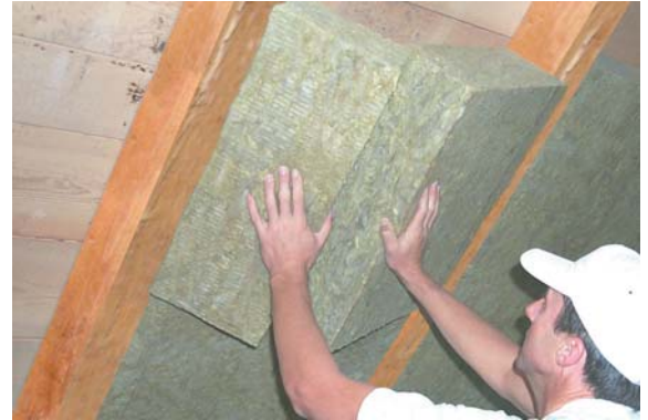
Reststücke zwischen die Sparren klemmen.
