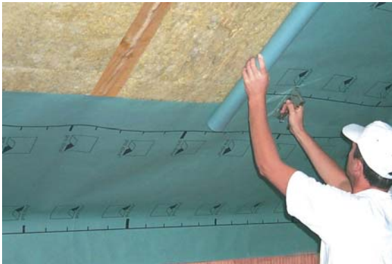
Befestigung der Dampfbremse pro clima DB+ durch Anklammern an die Holzunterkonstruktion.
