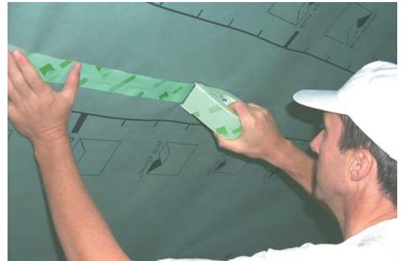
Ableben der Bahnüberlappungen mit pro clima TAPE.
