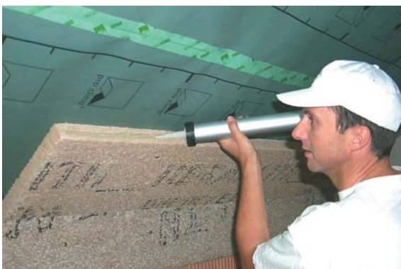
Aufbringen von Heraklith-BM-Kleber auf die Längsseite.
