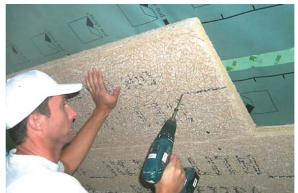
Befestigung von Heraklith-BM Platten mit Heraklith-Kompaktbauschrauben.
